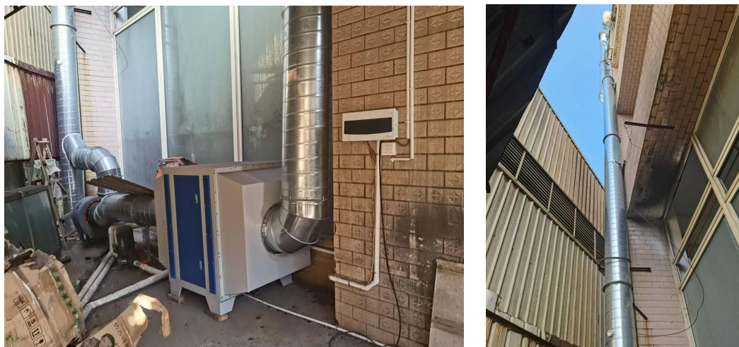
图 4-2 废气处理设施图
