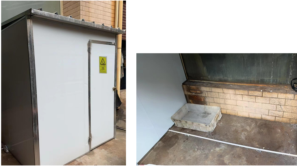
图 4-3 危险废物暂存场所图
